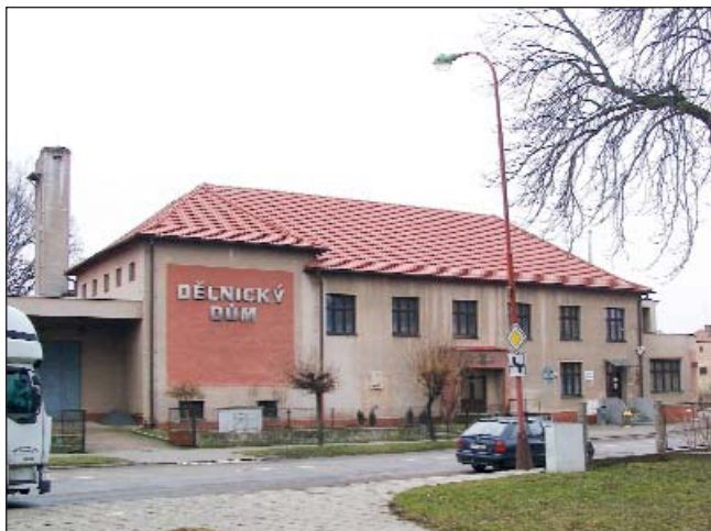
Skřivaný Dělňický dům projde rekonstrukcí.
